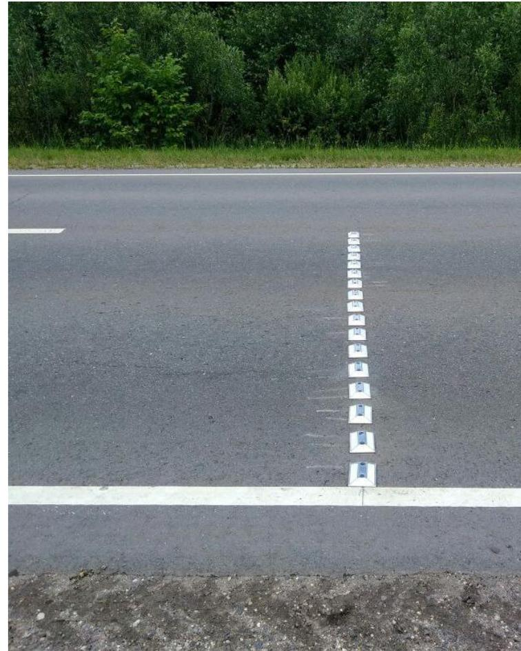
**Преимущества:** устанавливаются вместо шумовой полосы, более долговечны, визуализация в темное время суток, возможна установка круглый год
