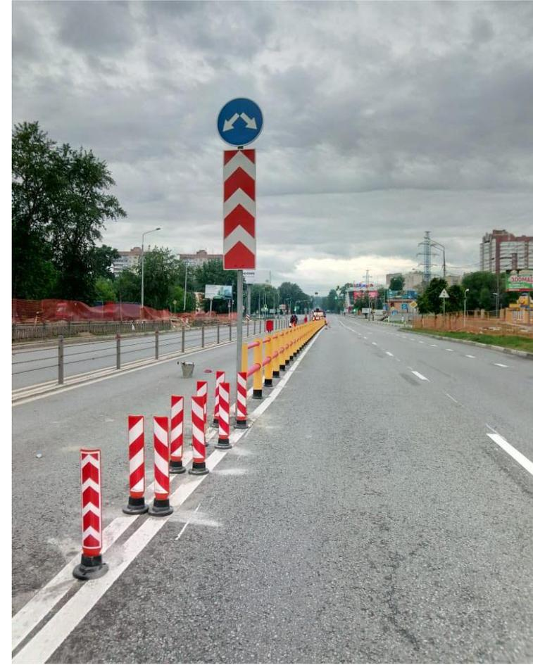
**Преимущества:** устанавливается вместо сигнальных столбиков, разделение транспортных потоков, сплошная конструкция препятствующая проезду т/с или прохождению пешеходов.
